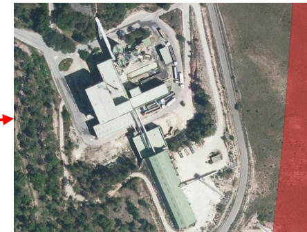
Centre d'exploitation d'une carrière
