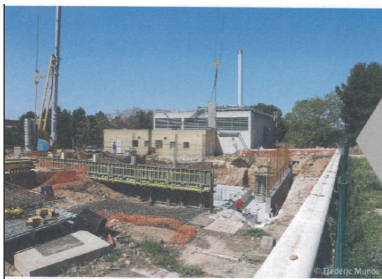
chaufferie de Canto-Perdrix, en chantier, passera du fioul au bois dès octobre.
