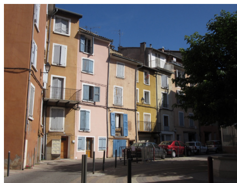
Figure 44. Façades entretenues, place Pied de Ville // AMOnites 2018
