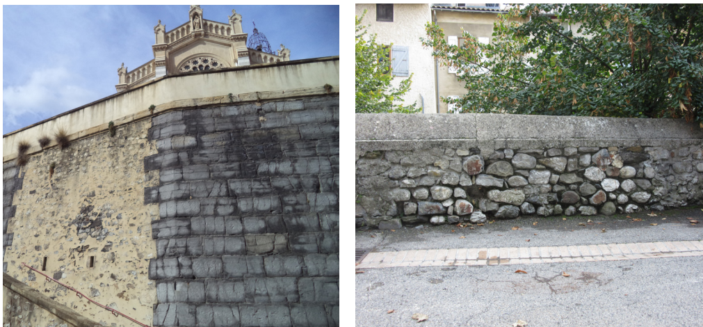
Figure 30. Des murs de pierre créant une ambiance minérale // AMOnites 2018
