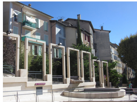
Figure 55. Cours du Tribunal, une entrée attractive // AMOnites, 2018
