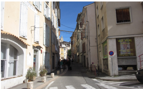
Figure 53. Rue de Provence, une entrée mal signalisée // AMOnites, 2018
