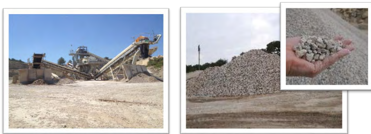
Figure 34 Valorisation de bétons issus de déconstruction
