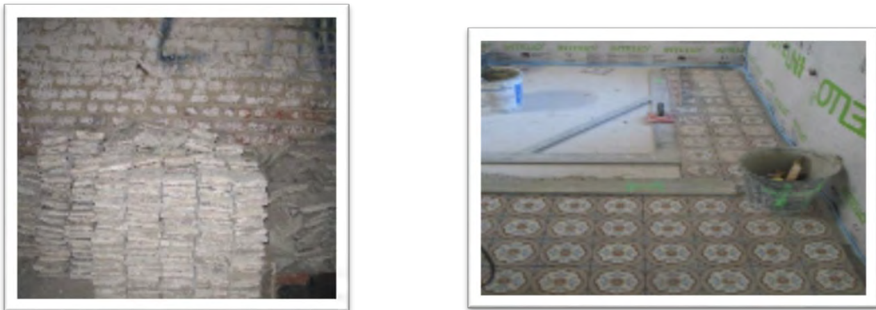
Figure 33 Dépose et repose de carreaux ciment de carrelage lors de la réhabilitation d'un bâtiment
