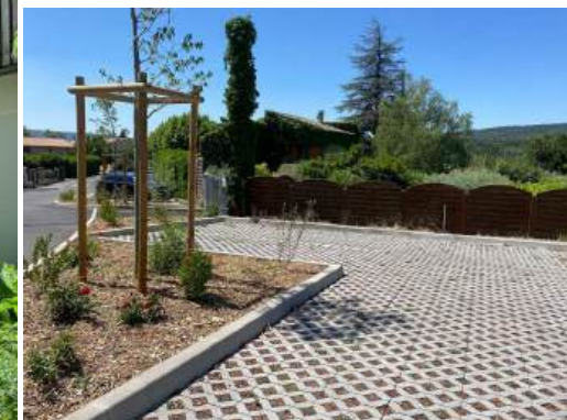
Desimpermeabilisation de parking
